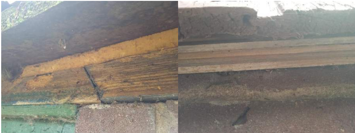
Foto links; de betimmering van het dakoverstek sluit naadloos aan op de buitengevels. Foto rechts; de houtbetimmering sluit ook naadloos aan op de buitengevels.
